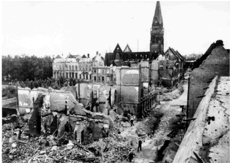
Inrather Straße mit St. Annakirche nach dem Bombenangriff
